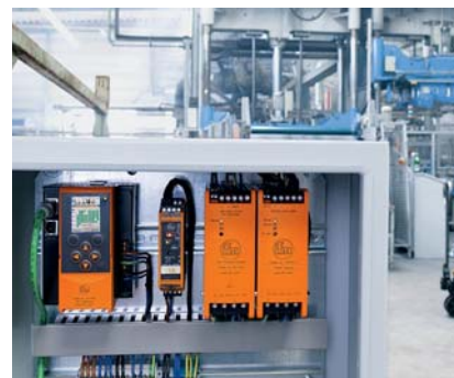
网关允许 AS-i与不同现场总线的连接。
