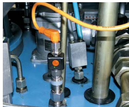
使用模块化TP变送器 代替普通头/ DIN导轨变送器。
