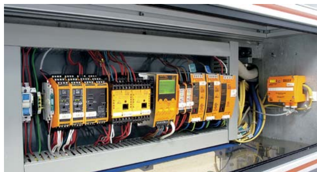
超薄的SmartLine模块也可以在小型控制柜中安装。
